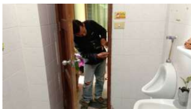
ซ่อมแซมประตูและเปลี่ยนลูกบิดประตู
