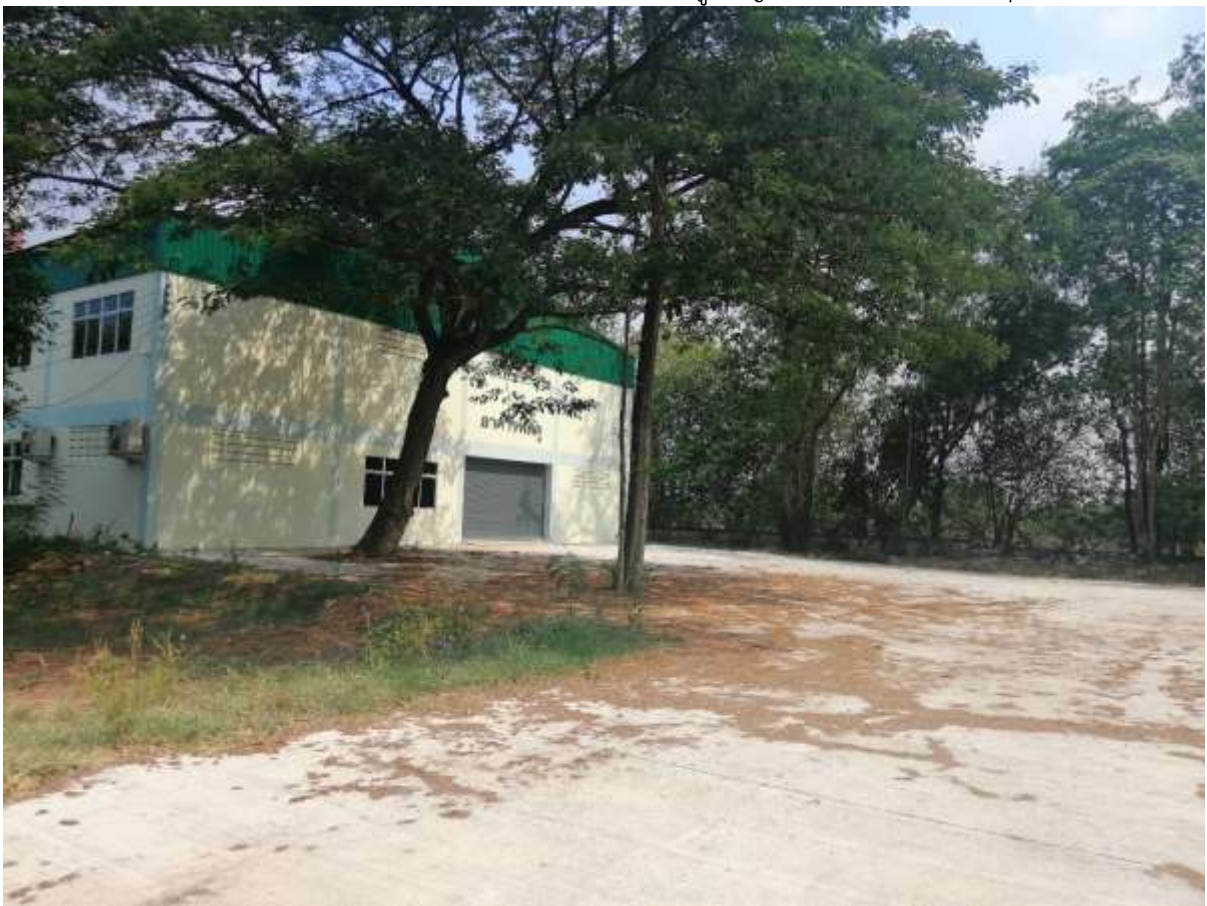
อาคารพัสดุ เทพื้นคอนกรีตหน้าอาคาร และทำทางคอนกรีตเข้าถึงตัวอาคาร
