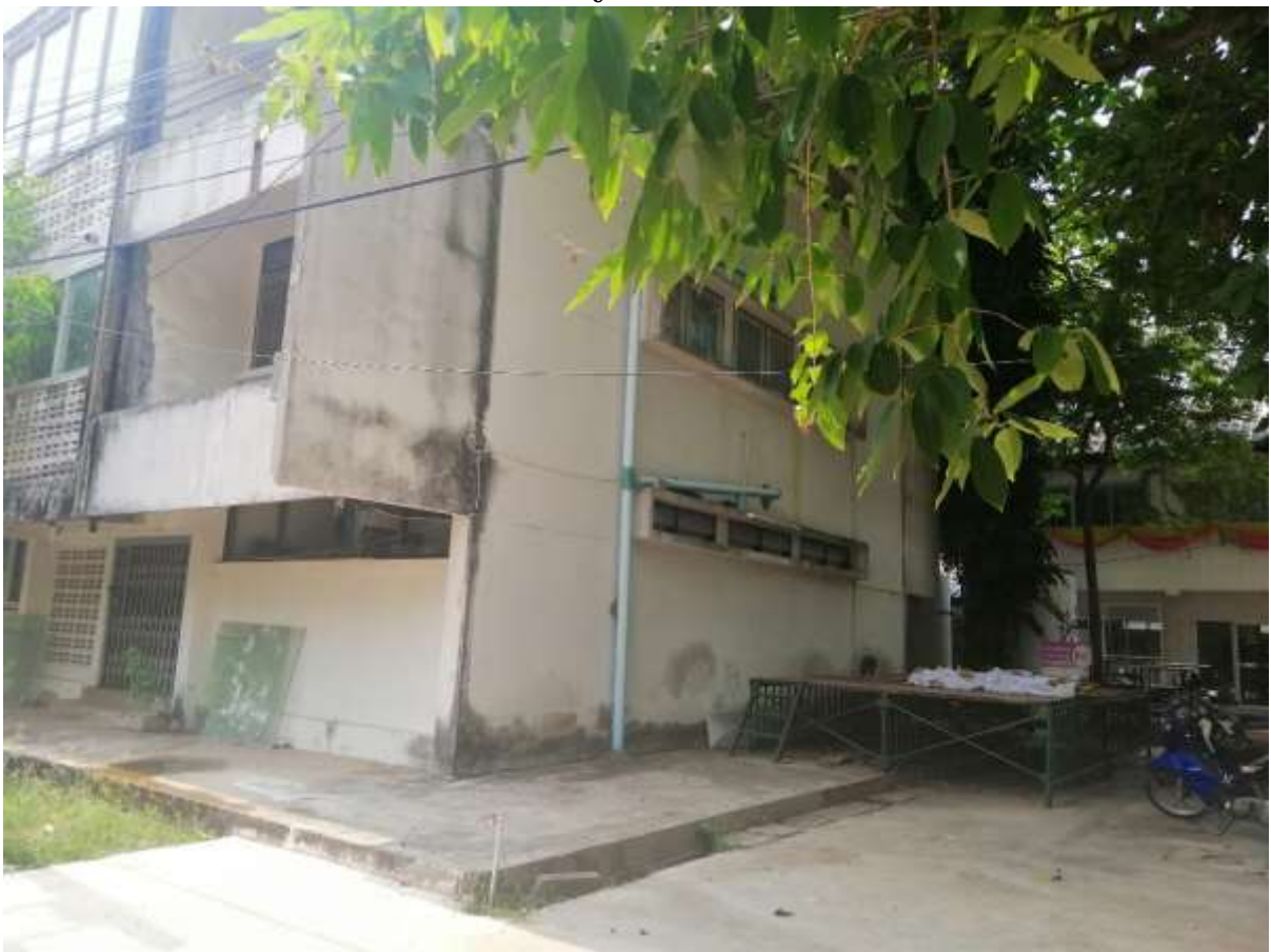
อาคารเรียน 10(ดนตรี) รื้อบอร์ดประชาสัมพันธ์ด้านข้างอาคารและติดตั้งเวทีชั่วคราวไว้
