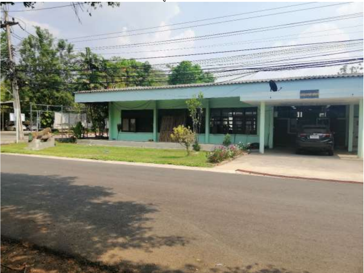
อาคารเรียนเกษตร รื้อเพ็องฟ้าประดับข้างทางออก และปลูกหญ้ารวมถึงไม้ประดับอื่นๆ หน้าอาคาร
