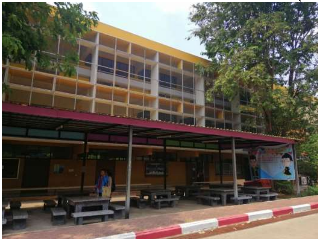
อาคารเรียน 1 ทำเชิงหลังคากันแดดกันฝนและเพิ่มโต๊ะเก้าอี้ม้าหินด้านหน้าอาคาร
