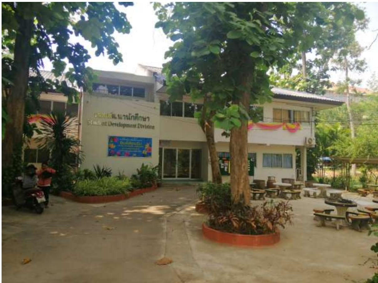
อาคารกองพัฒนานักศึกษา เทพื้นคอนกรีตด้านหน้าและปรับเปลี่ยนไม้ประดับจุดต่างๆ
